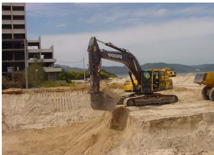
Fig. 4 – Acompanhamento da escavação mecânica na área dos apartamentos da marina.
