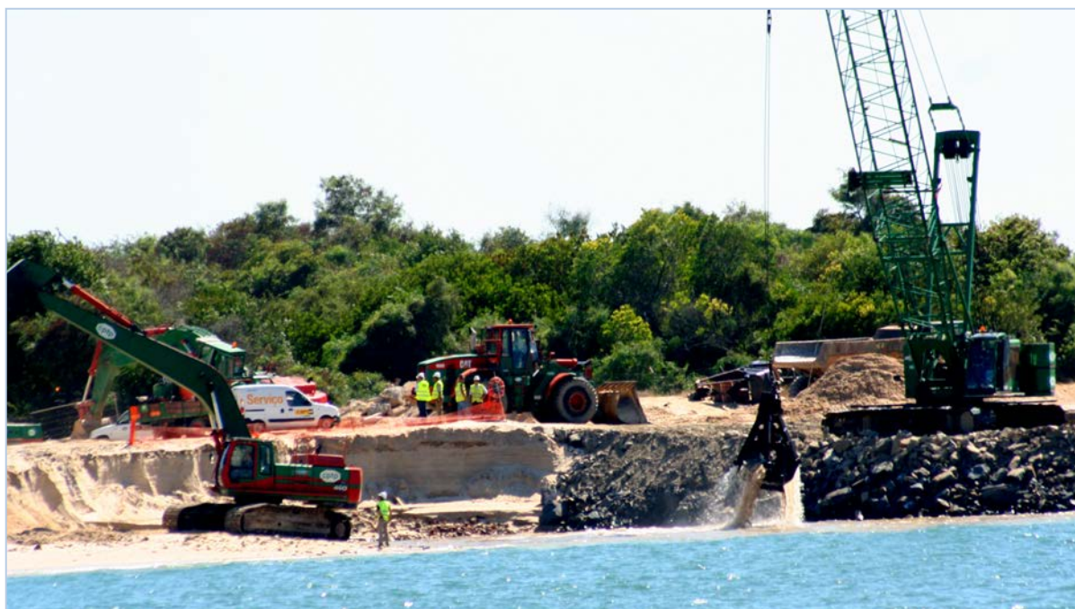
Fig. 6 – Acompanhamento arqueológico da remoção de sedimentos, por escavação mecânica, na área de implantação da marina.
