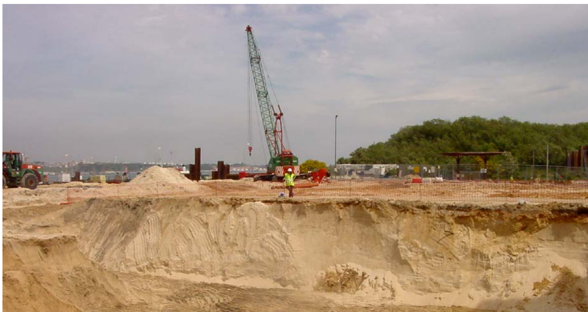
Fig. 5 – Acompanhamento arqueológico da remoção de sedimentos, por escavação mecânica, na área de implantação da marina.
