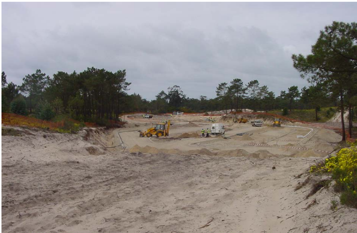
Fig. 17 – Aspecto dos trabalhos desenvolvidos na execução das infraestruturas terrestres de acesso ao cais dos ferries.
