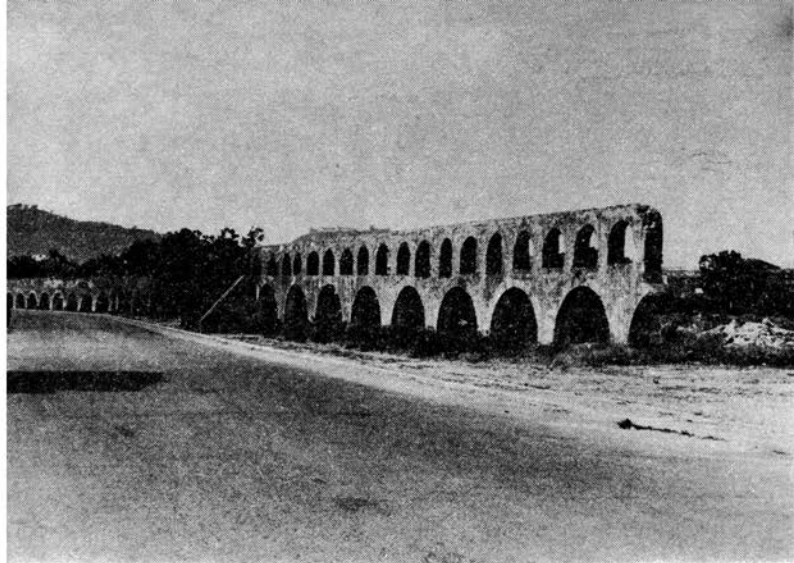
Aqueduto que fornecia água a Setúbal.
