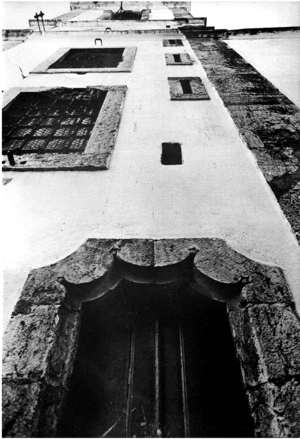
Porta lateral da Igreja de S. Julião.
