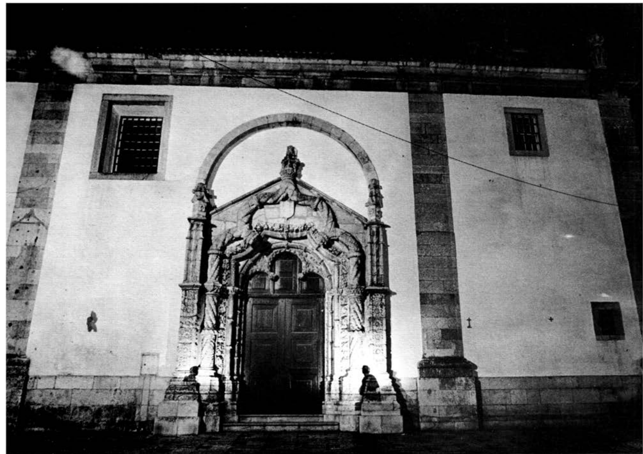
Portal Norte da Igreja de S. Julião.
