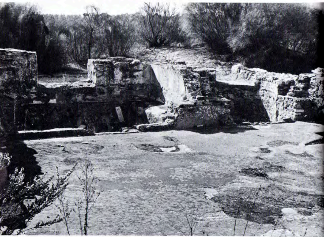
Fig. 130 — Tróia de Setúbal. Sala do balneário, com tinas destinadas aos banhos frios ( frigidarium ).
