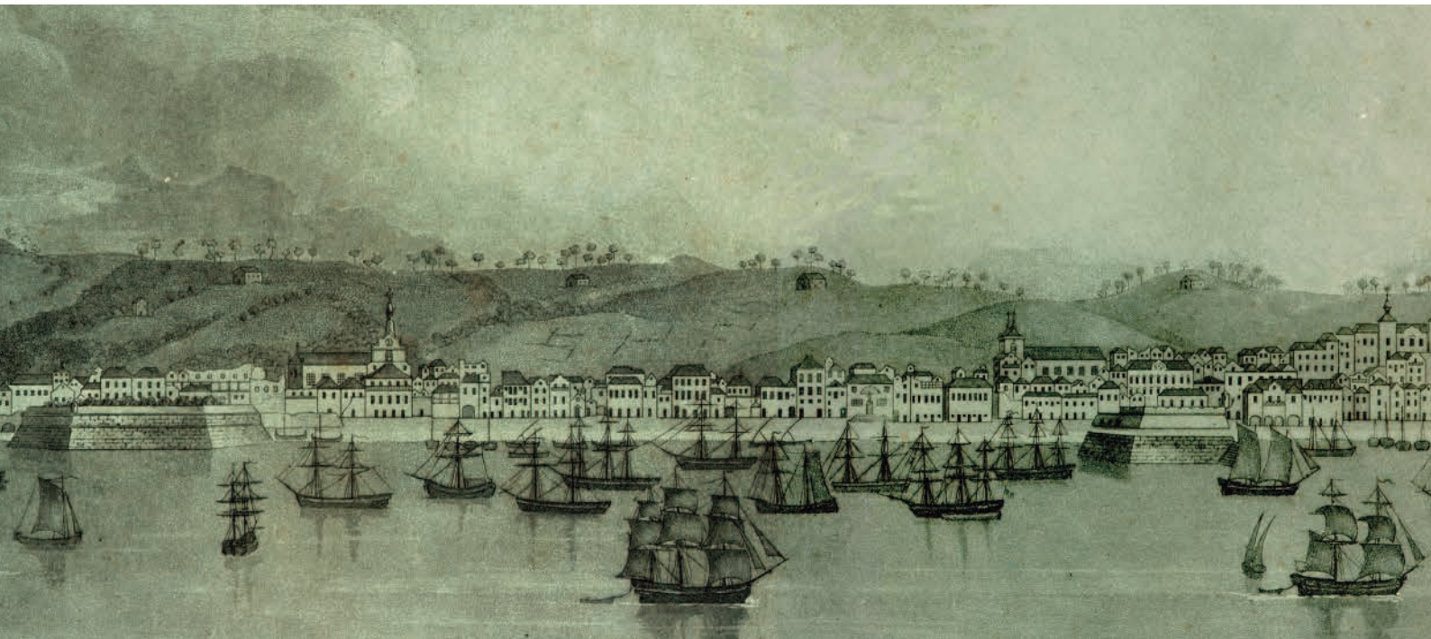
Fig. 3 - Excerto de gravura da frente ribeirinha de Setúbal, 1827. Na gravura são visíveis os estragos causados pelo tsunamis no pano de muralhas do séc. XVII, tendo restado apenas os baluartes. À esquerda, baluarte do Livramento, e à direita, o baluarte de Nossa Sra. da Conceição ou do Cais. Gravura de J.X. d'O. Banha, B. Comye, Lisboa.
