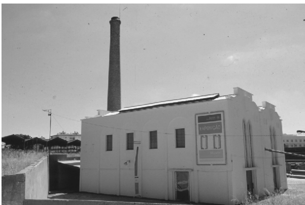
Antiga Fábrica de Cortiça Mundet & Cª no Seixal. Edifício das Caldeiras Babcock (Núcleo do EMS). Ecomuseu Municipal do Seixal/CDI Rosa Reis, 2000.
