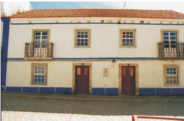
Fig. 6 - Melides. Aspecto do património construído. Séculos XVIII/XIX.
