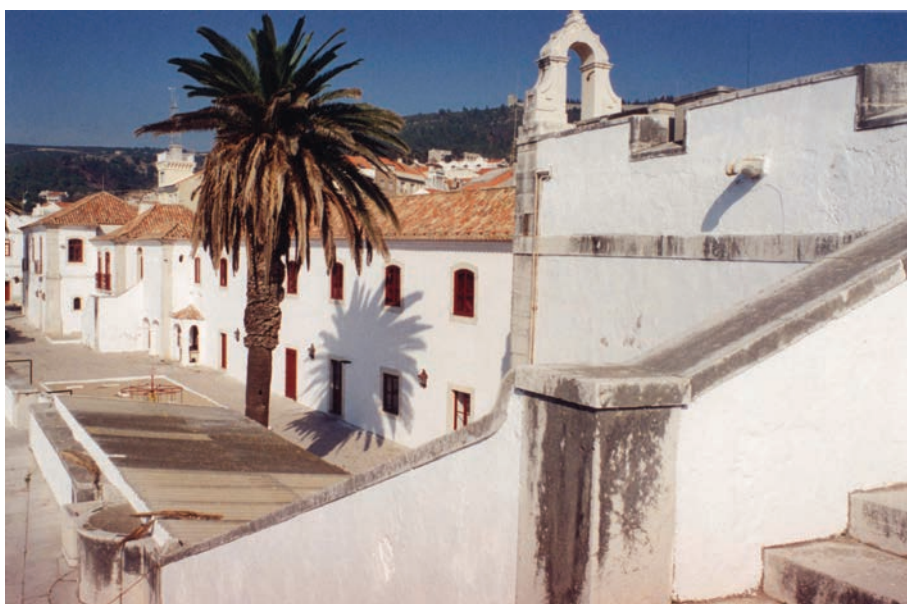
Fig. 5 - Interior da Fortaleza de Santiago. Foto da C.M. Sesimbra – GIRP Arquivo Fotográfico.
