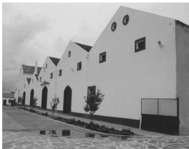
Fig. 5 - Fachada poente da Adega de Algeruz.
