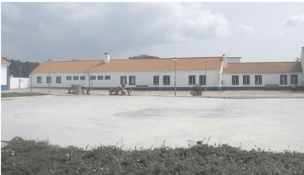
Fig. 2 - Monte do Paio, transformado em Centro de Acolhimento. Em primeiro plano, a eira.
