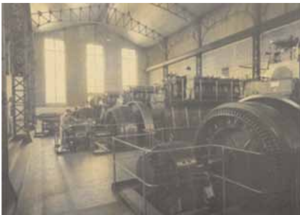
Fig. 5 - Central Diesel da década de 50, em plena laboração.
