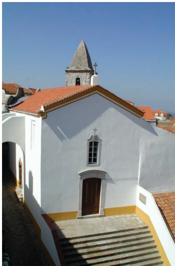
Fig. 4 - Igreja da Misericórdia de Santiago do Cacém, com a nova fachada de 1769.
