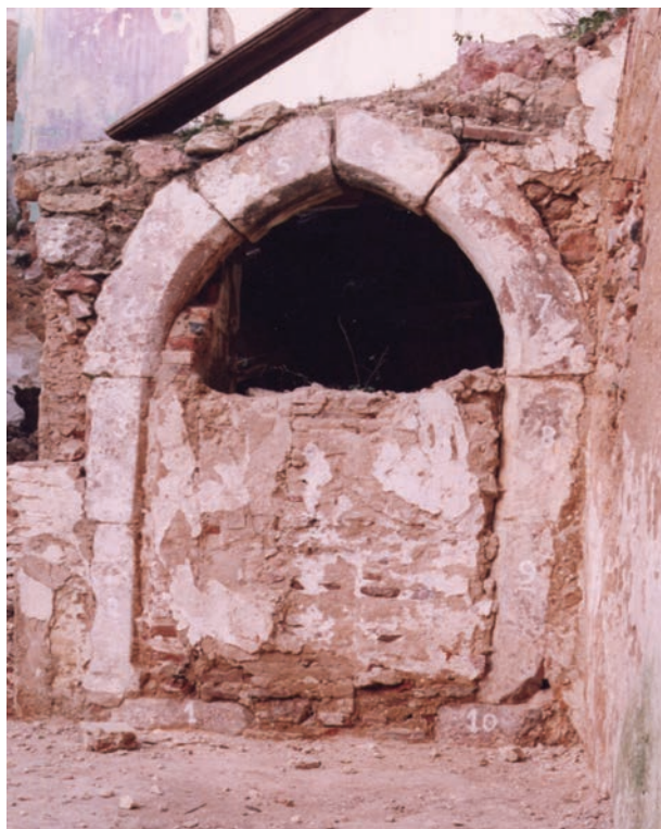
Fig. 29 - Portal gótico descoberto durante a demolição de um edifício na Rua Padre António de Macedo (antiga Rua da Almas) em 1985; hoje já não existe como arco gótico.
