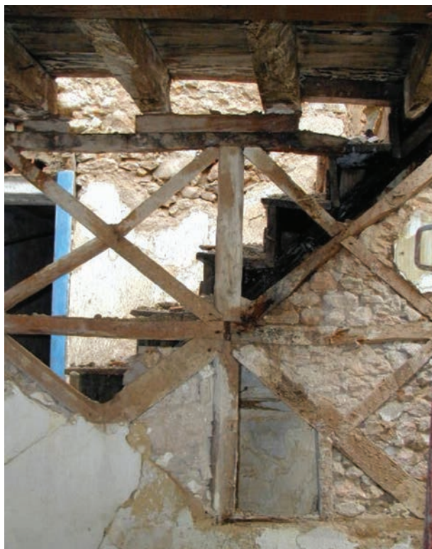
Fig. 33 - Estrutura em gaiola pombalina posta a descoberto durante as obras realizadas em 2004 num edifício situado na Rua Dr. Francisco Beja da Costa, demolida na mesma altura.
