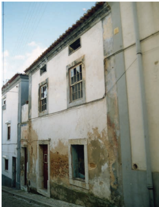
Fig. 34 - Fachada do edifício onde foi descoberta a estrutura da imagem anterior; foto tirada antes das obras, quando, apesar do abandono, ainda mantinha uma imagem muito autêntica da reconstrução pós-terramoto.
