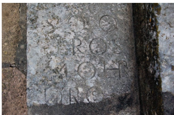
Fig. 7 - Pormenor da escadaria da Igreja da Misericórdia; aproveitamento de tampas de sepultura na reconstrução.
