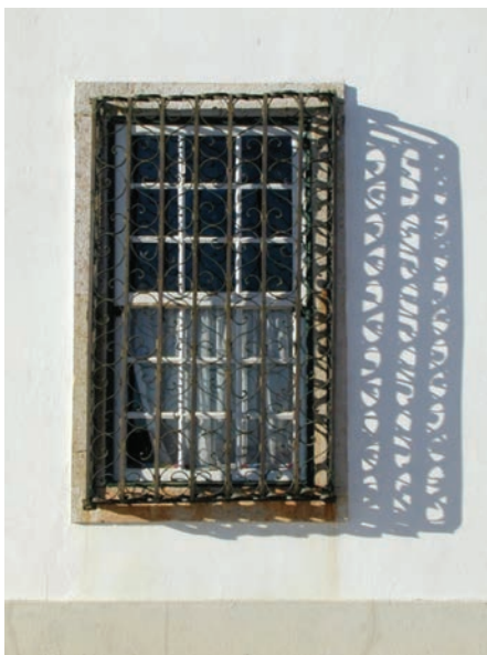
Fig. 13 - Janela de guilhotina na Casa do Prior, Rua Condes de Avelaz (antiga Carreira).
