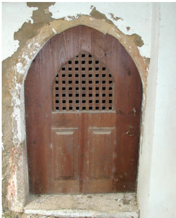
Fig. 27 - Portal gótico em edifício na Rua Dr. Francisco Beja da Costa (antiga Rua Direita).
