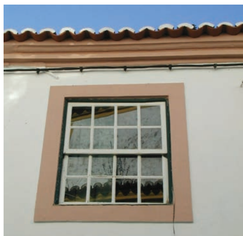
Fig. 16 - Janela de guilhotina em habitação na Rua Padre António de Macedo (antiga Rua das Almas).
