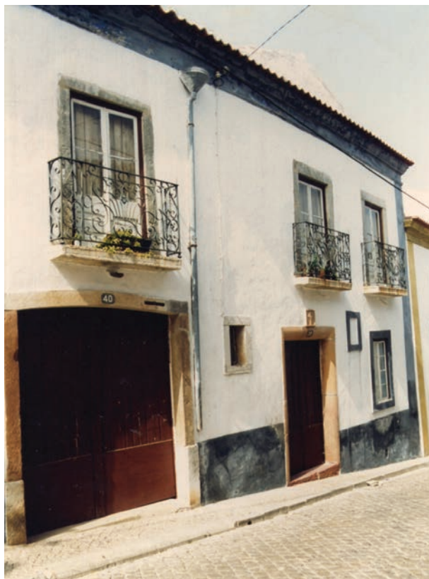
Fig. 25 - Casa da Colegiada, na Rua Padre António de Macedo (antiga Rua das Almas), edifício cuja fachada, datada de 1733, se mantém.
