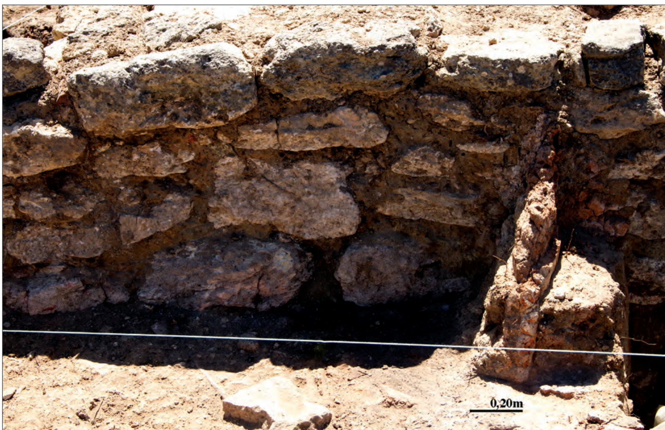
Fig. 18 - Chibanes. Torre T7. Paramento norte do muro (m. 38) que segmentou a torre T7 (vista de norte), ao qual se encosta adobe queimado, tombado da parte superior da estrutura.
