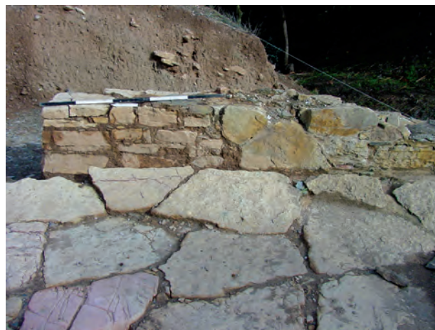
Fig. 6 - Extremidade norte da guarda este da ponte. Repare-se na diferença do aparelho da guarda original (à esquerda, sob a escala), escavada nesta campanha, e da guarda reconstruída no século XX (à direita daquela).
