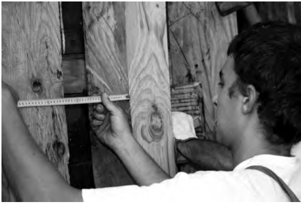
Fig. 8 - Medir com fita para ajustar as distâncias entre os dois braços e acertar o respectivo braço que está a ser montado (Foto de Paulo Guerreiro).
