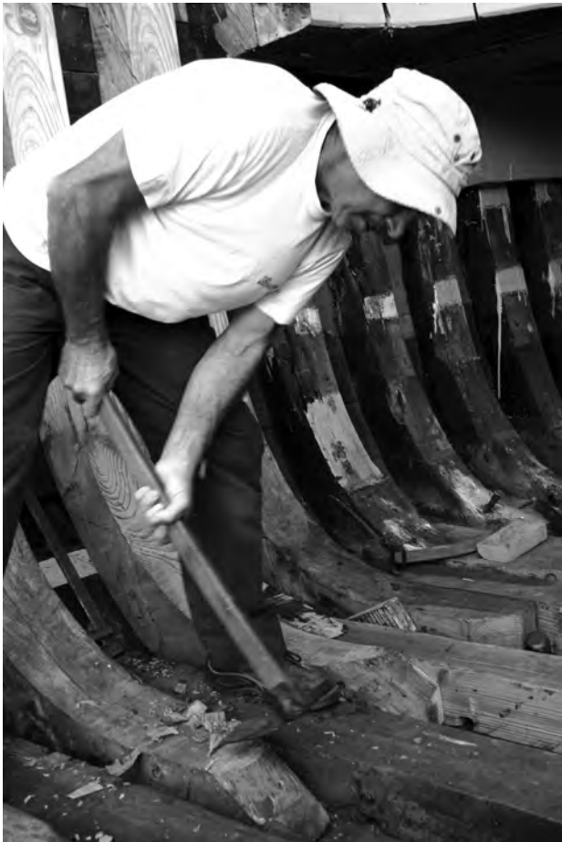
Fig. 9 - Retirar o excedente de madeira com a enxada de cabo, para acertar a zona do encolamento (ligação do braço com a caverna). Foto de Paulo Guerreiro.
