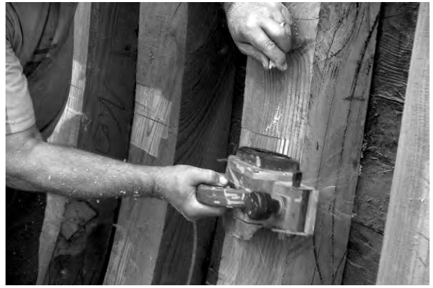
Fig. 10 - Marcar e aparar o braço com plaina eléctrica (Foto de Paulo Guerreiro).
