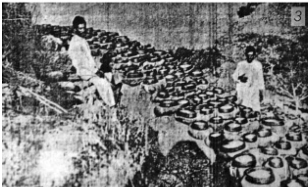
Fig. 15 - Petits bassins destinés à l'évaporation de l'eau salée (Mexique). 1 et 2- Salines de San Francisco, Tejulpilco, Estado de México ; 3- Terrasse d'une des salines de l'Etat de México – (dessin de C. Badillo ; photos V. Osorio et J. García 1933).
