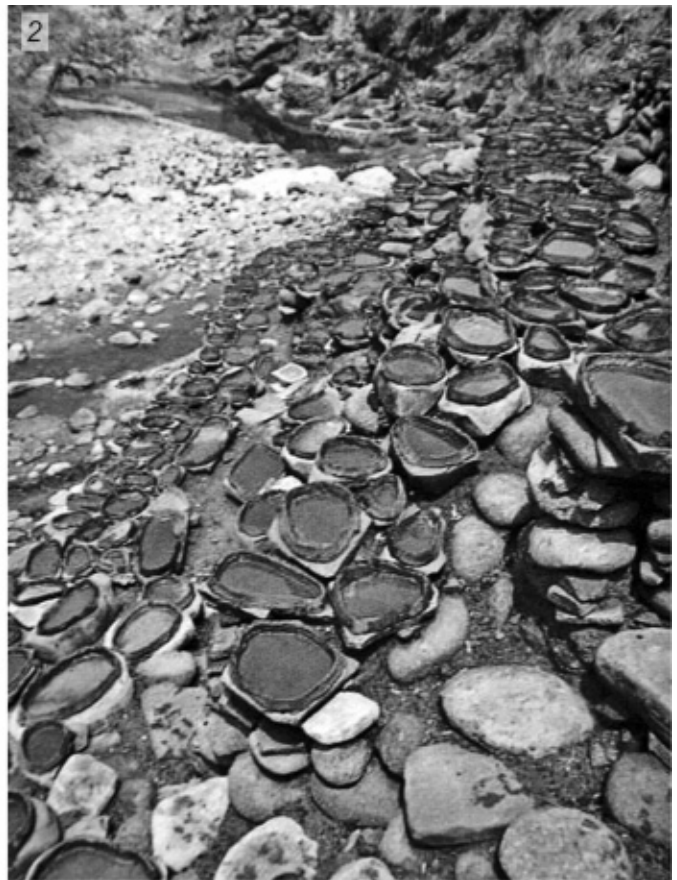
Fig. 15 - Petits bassins destinés à l'évaporation de l'eau salée (Mexique). 1 et 2- Salines de San Francisco, Tejulpilco, Estado de México ; 3- Terrasse d'une des salines de l'Etat de México – (dessin de C. Badillo ; photos V. Osorio et J. García 1933).
