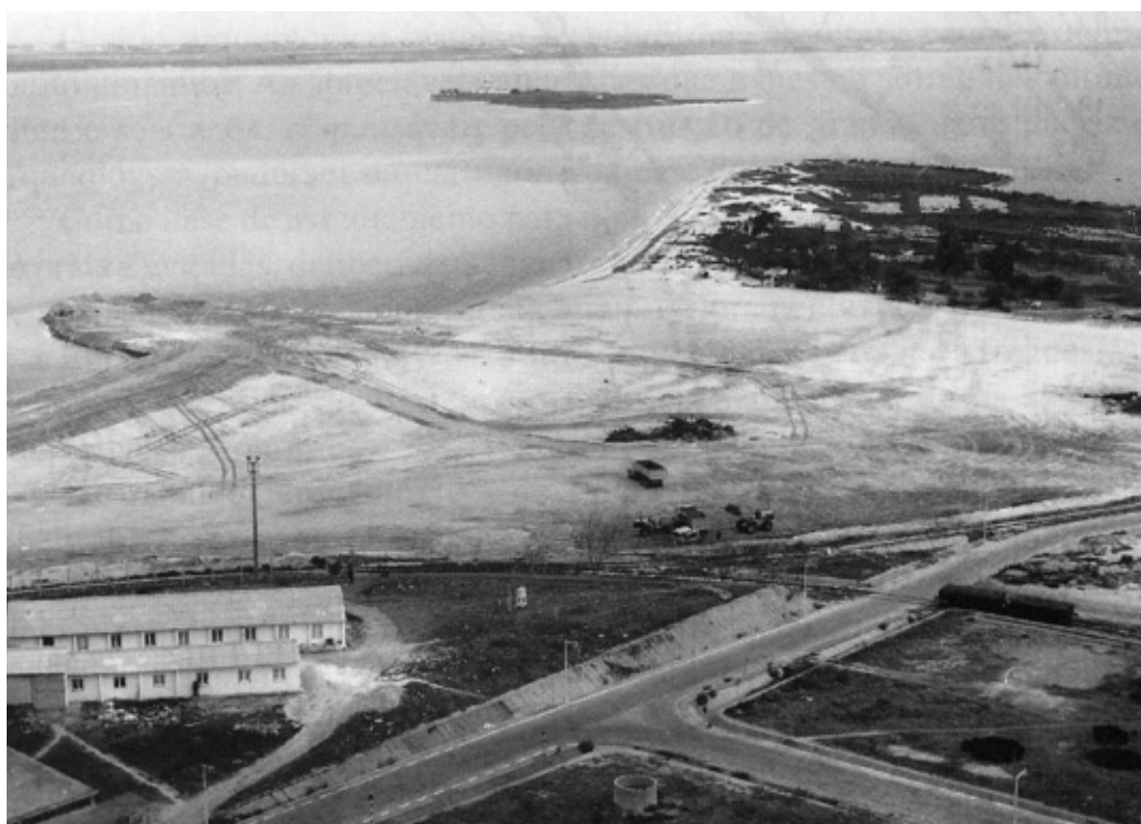
Fig. 3 - Vista aérea da Ponta da Passadeira, em 1973, aquando dos trabalhos de terraplenagens para a construção da fábrica Fisipe. Em penúltimo plano, a ilha do Rato. Arquivo da Quimiparque.
