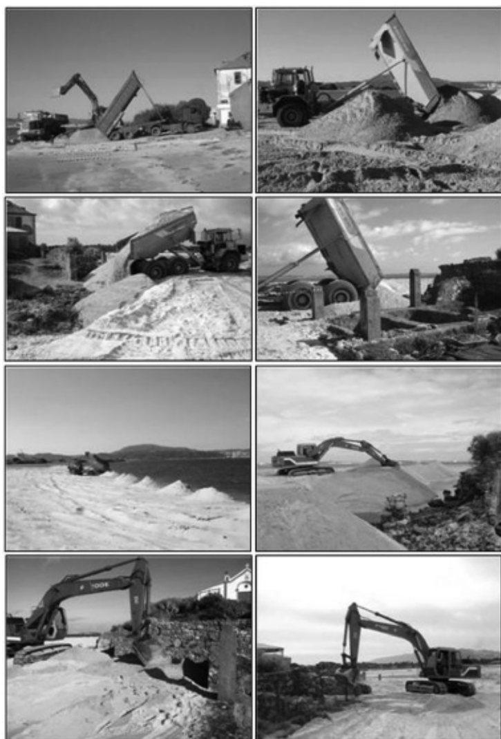
Fig. 8 - Aspectos da execução do enchimento de praia (Maio de 2007).
