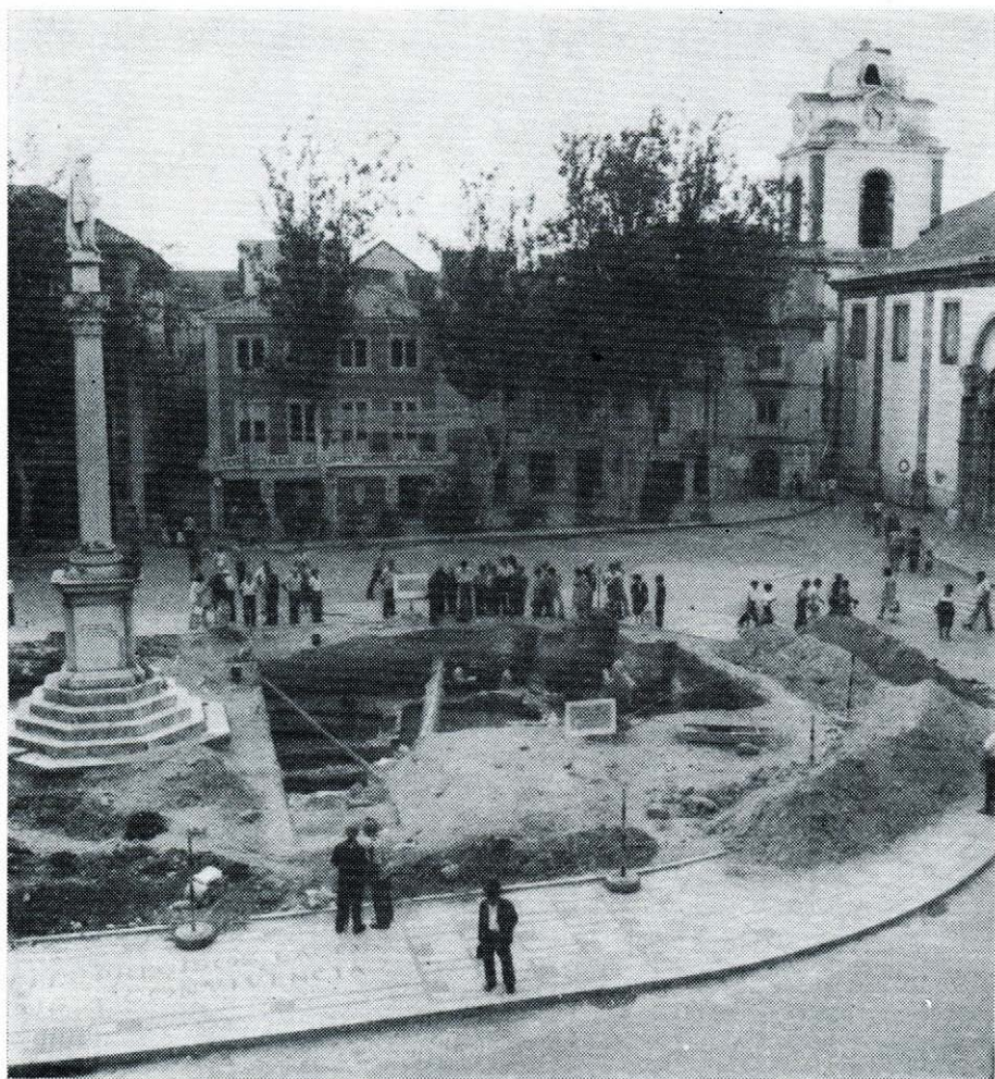
Fig. 3 — Aspecto geral da escavação.
