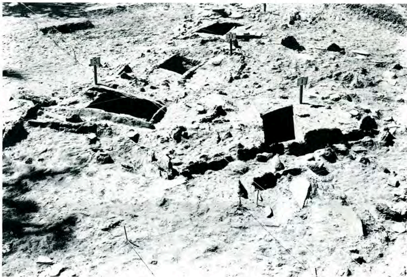
Fig. 113 — Vista parcial do núcleo Norte do monumento I da Provença.
