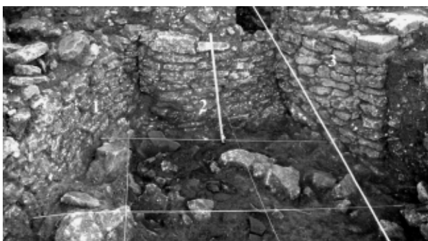
Fig. 15 – Chibanes. Muralha (1) e torre (2) da II Idade do Ferro e muro interior (3) da fortificação “abaluartada” da zona ocidental, do Período Romano Republicano. Foto arquivo MAEDS.
