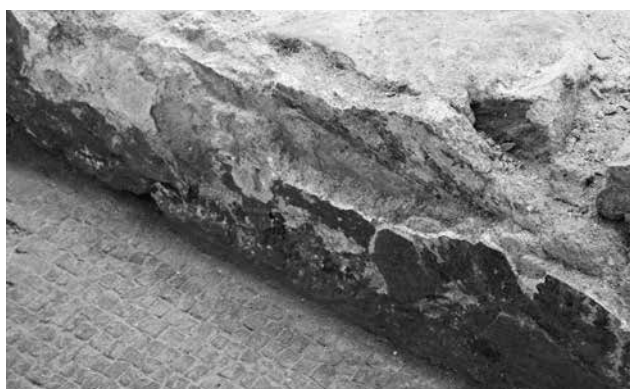
Fig. 9 Rua António Joaquim Granjo, 19. Revestimento do muro 2 por camadas de estuque pintado (Sala I).
